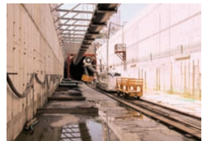
La entrada al túnel, en Tula, Hidalgo
