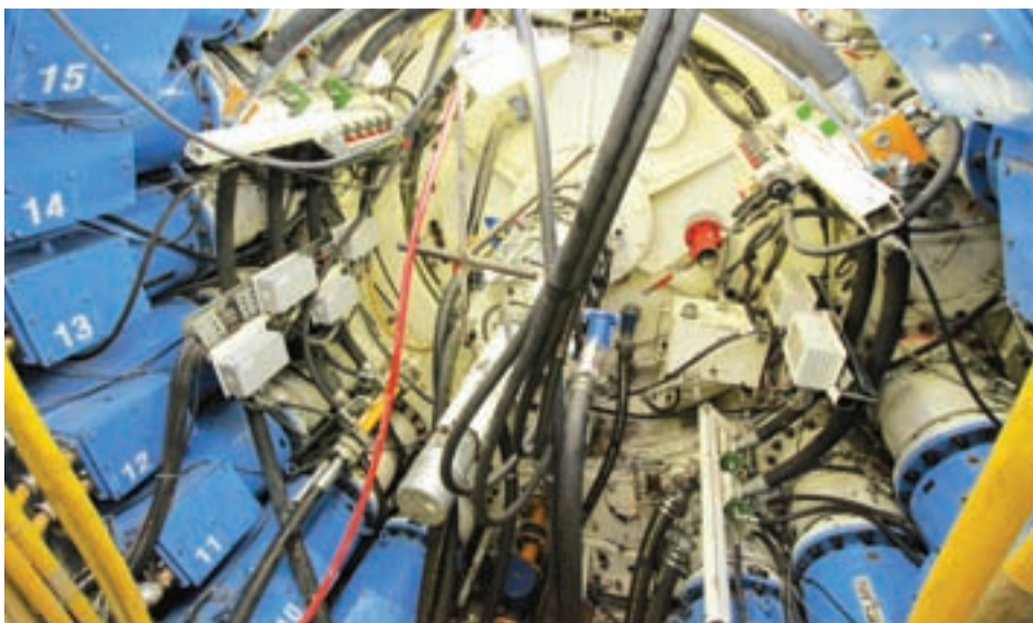
Vista posterior de la poderosa tuneladora
