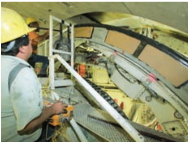
Una ventosa mecánica levanta una dovela
